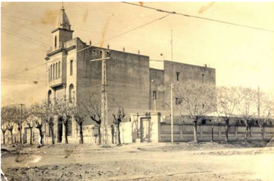
Figura 16. Vista lateral del Colegio - Asilo Niño Jesús de Praga en Villa Luzuriaga
