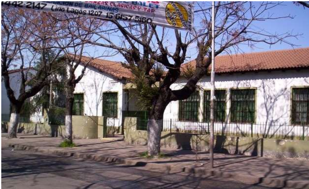
Figura 24. Vista del edificio de la escuela n°18 Bartolomé Mitre, en Aldo Bonzi. Fuente: Aldo Bonzi web.
