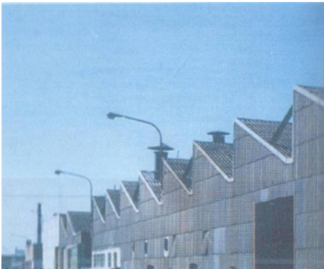
Aspecto exterior de los galpones de la calle central
