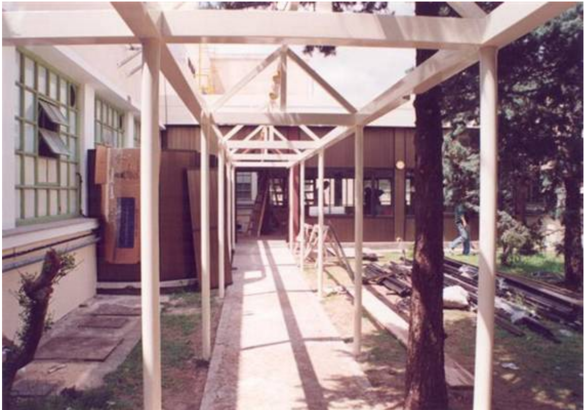
Construcción del Primera Biblioteca
