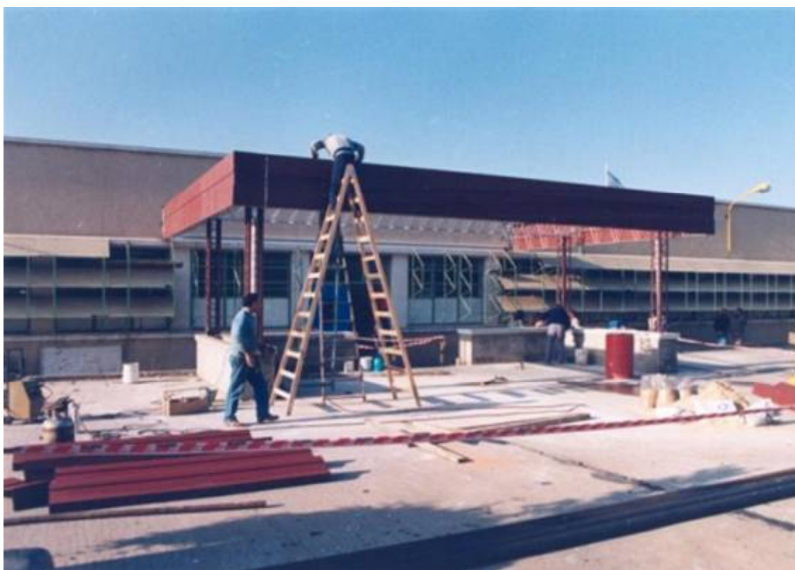
Construcción de entrada al Sector Pérez Esquivel
