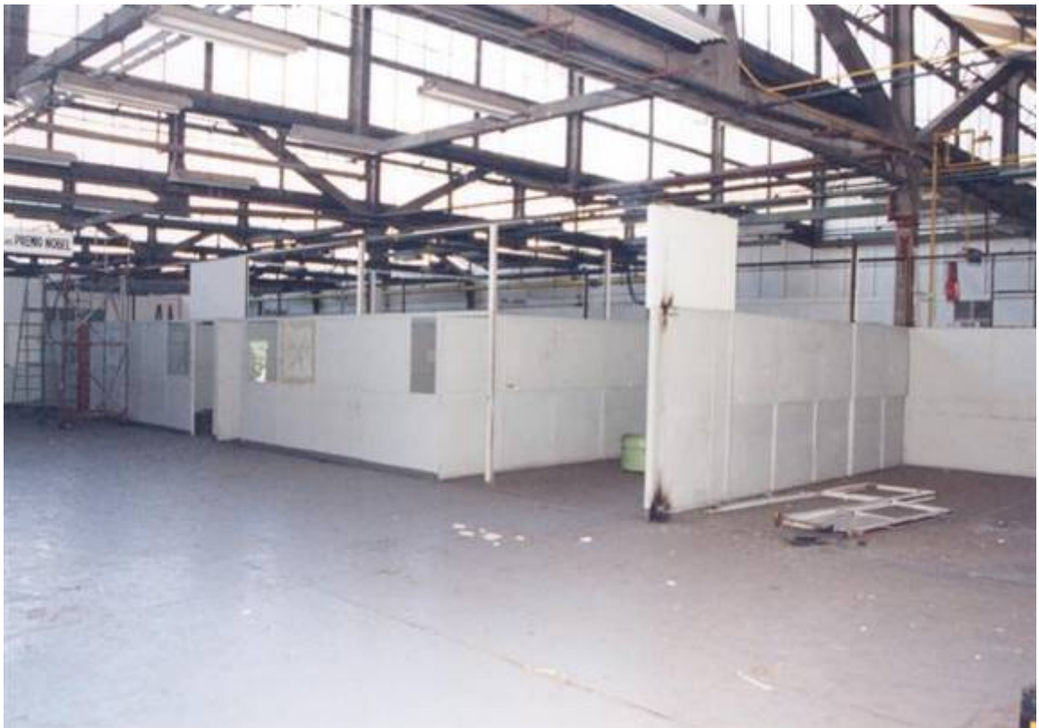
Se desmantelan las primeras aulas
