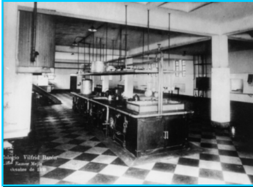
Cocina del colegio
