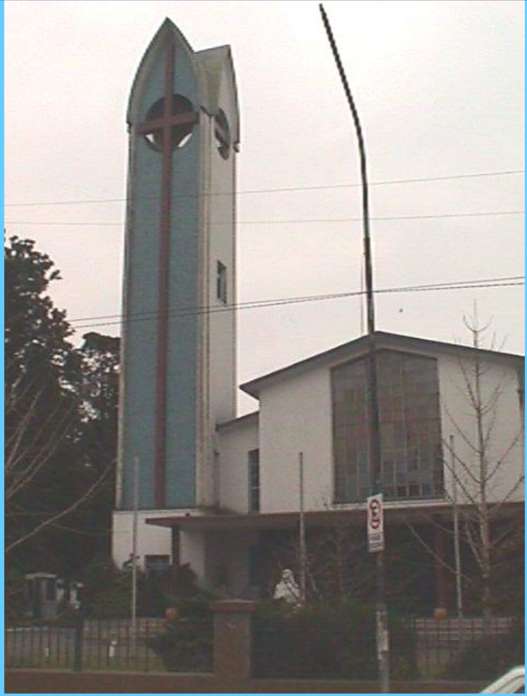
Capilla actual del Hospital San Juan de Dios
